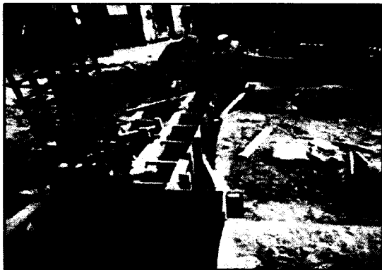
Imagen 17 y 18. Encofrado en zapatas.
