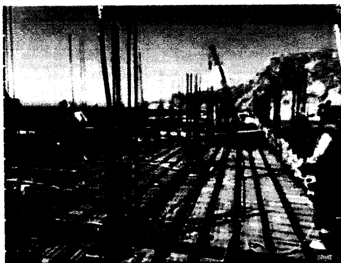
Imagen 8. Vaciado de losa aligerada en zona de frio.
